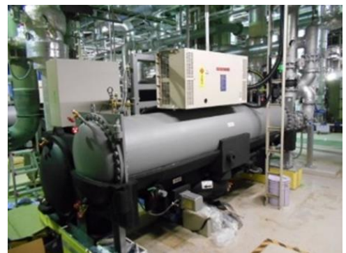
新冷媒採用ターボ冷凍機
