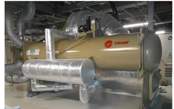
ノンフロン冷媒採用ターボ冷凍機
