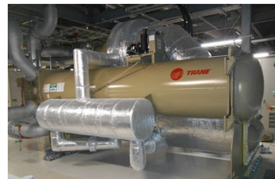
ノンフロン冷媒採用ターボ冷凍機
